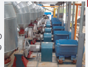
Linha BEN OT BOMBAS HORIZONTAIS PARA ÓLEO TÉRMICO ISO 2858 - ISO 5199
